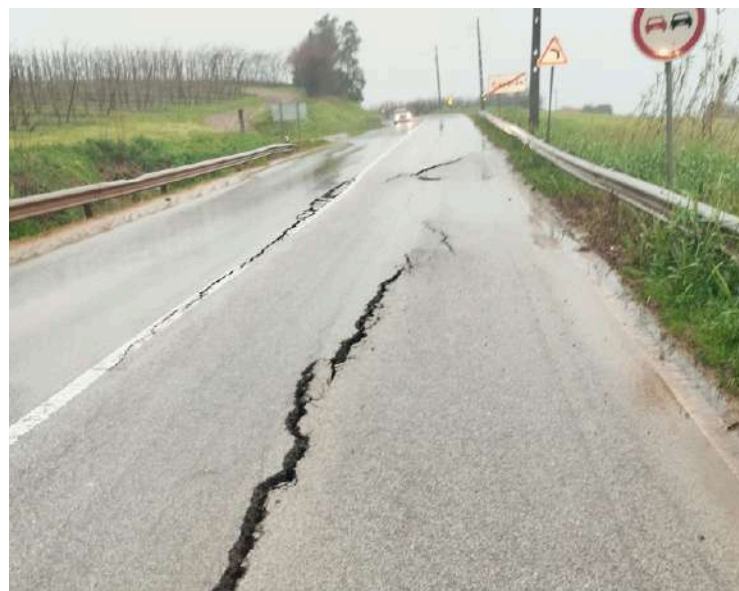
Fendas no alcatrão na EN115, ao km 12.5, na localidade de Casarão, na União de Freguesias de Painho e Figueiros, Cadaval, sob avaliação da Infraestruturas de Portugal
