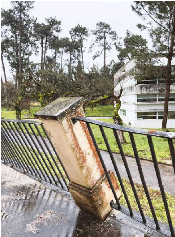
Pilar com guarda metálica que cedeu na Escola Superior de Artes e Design das Caldas da Rainha
