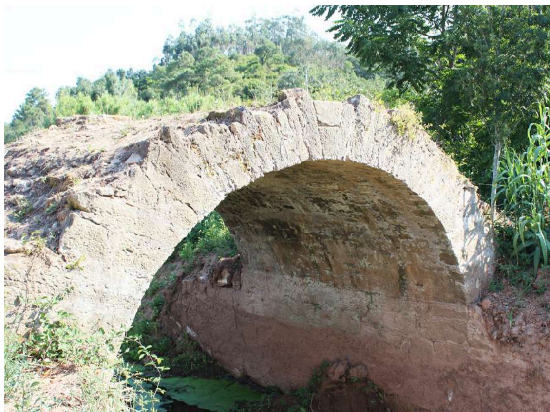
Ponte da Feteira, tornada visível em 2018 após limpeza da área envolvente
