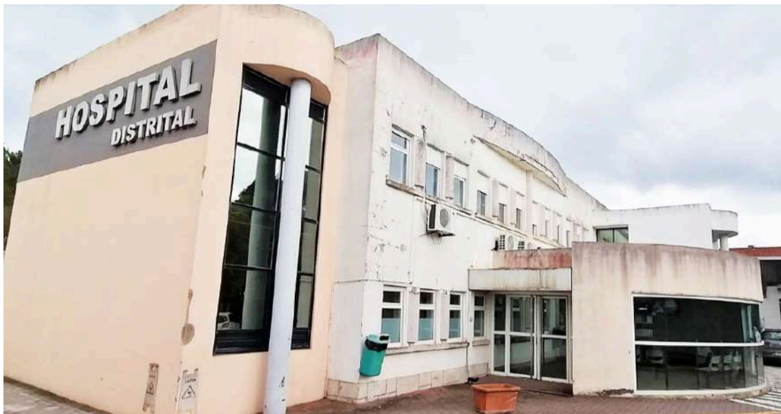
Esta obra incluirá diversas intervenções que irão melhorar a durabilidade do edificado
