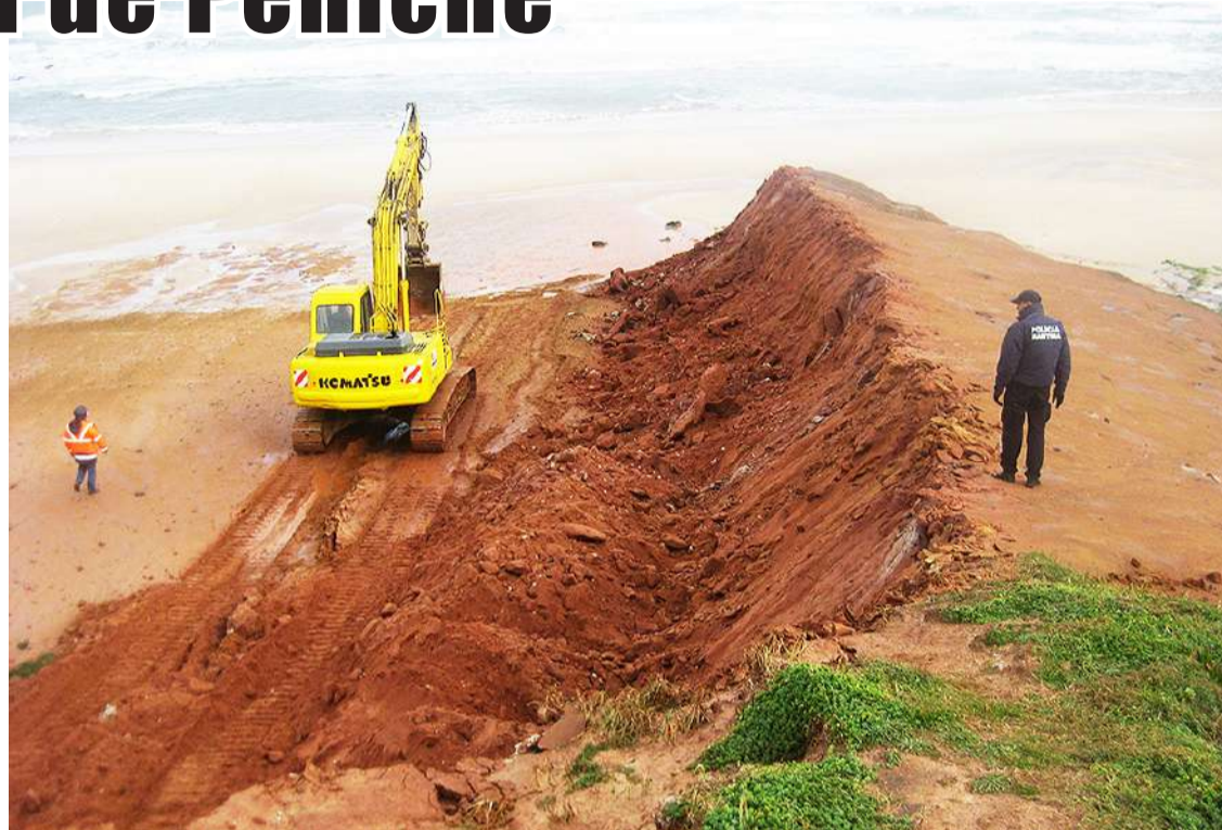
Saneamento de uma arriba em elevado perigo de derrocada na praia da Almagreira, em 2016
